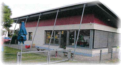
Außenansicht der Kinderkrippe Sandhäsla
